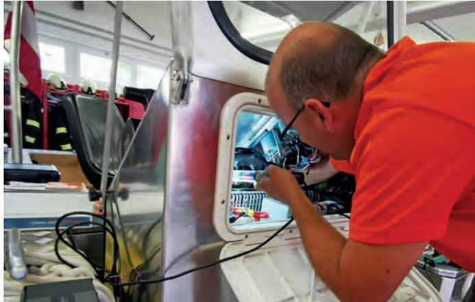
Die Umstellung auf Digitalfunk bedeutete auch, dass alle Funkgeräte in den Fahrzeugen und Booten getauscht werden mussten.
