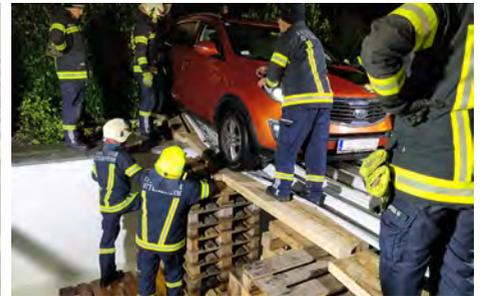
*Mit vorsichtiger und bedachter Arbeitsweise konnte der PKW durch den Unterbau von Paletten und Kanthölzern so stabilisiert werden, dass das Fahrzeug mittels Seilwinde gefahrlos geborgen werden konnte.*
