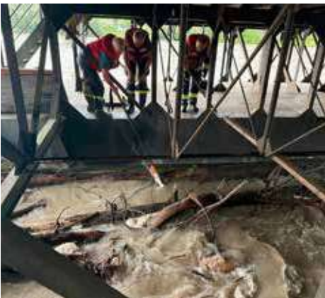
v.l.n.r.: Enorme Mengen von Treibgut hatten sich zwischen den Schwimmkörpern verfangen. Mit Motorsägen, natürlich gesichert, wurde das Holz Stückweise abgeschnitten. Zuletzt wurde die Schwelle der Fähre noch mit einem Kettenzug angehoben und der Rest dann durchgedrückt.
