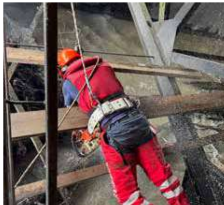
v.l.n.r.: Enorme Mengen von Treibgut hatten sich zwischen den Schwimmkörpern verfangen. Mit Motorsägen, natürlich gesichert, wurde das Holz Stückweise abgeschnitten. Zuletzt wurde die Schwelle der Fähre noch mit einem Kettenzug angehoben und der Rest dann durchgedrückt.
