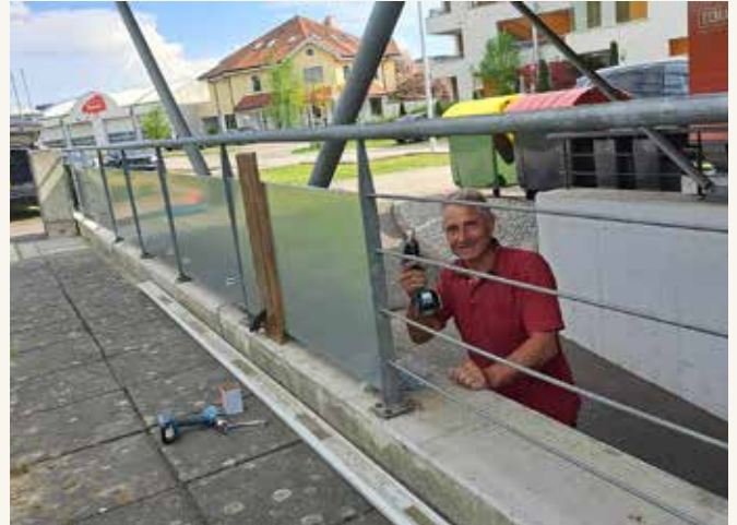
Karl Widmann, hier schwer bewaffnet mit dem Akkuschauber, und Klaus Mayer montierten heuer im April eine dauerhafte Lösung aus verzinkten Blechtafeln bei unserem Gelände zur Kellerabfahrt.
