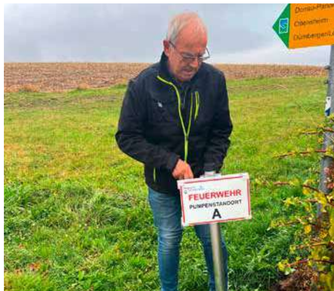
Adi Aichhorn und Andreas Putz montierten die neuen Pumpenstandorttafeln am Dürnberg, um im Einsatzfall schneller und sicher Löschwasser zu betroffenen Objekten zu bringen.
